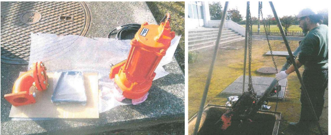
10月末にトイレ等の排水が悪くなり、保守業者様に確認していただいたところ、原水槽に設置してある投入ポンプが経年劣化により故障し、次槽への排水移行を十分に行えず、原水槽の水位が上昇し、トイレ等の水回りの詰まりが発生していると報告を受けたため、交換工事をしていただきました。
