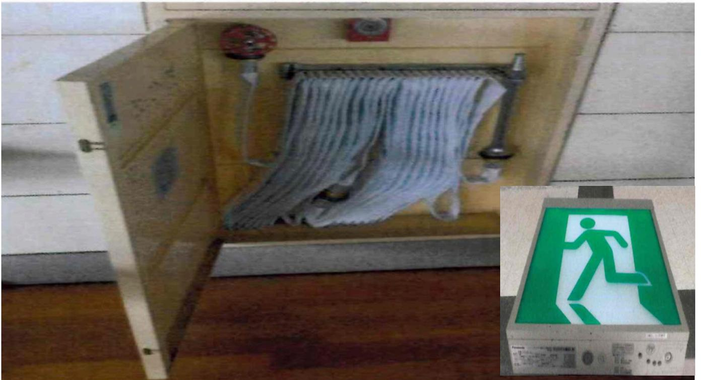
保守業者の点検「屋内消火栓設備点検票」の中で製造から10年経過したホースがあると指摘を受けたため、取替工事をしていただきました。
